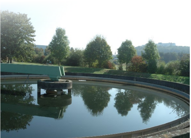
Nachklärbecken einer kommunalen Kläranlage.
